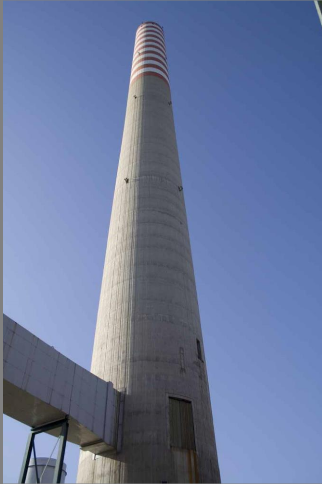
Il camino dismesso alto 150m.
